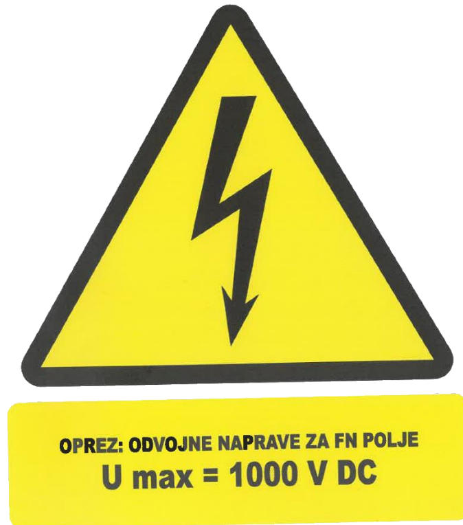
Oznaka na DC ormariću elektrane
